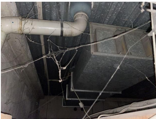
links Abluftanlage Hallenteil im Deckenholraum / rechts Abluftausblas und Außenluftansaugung
