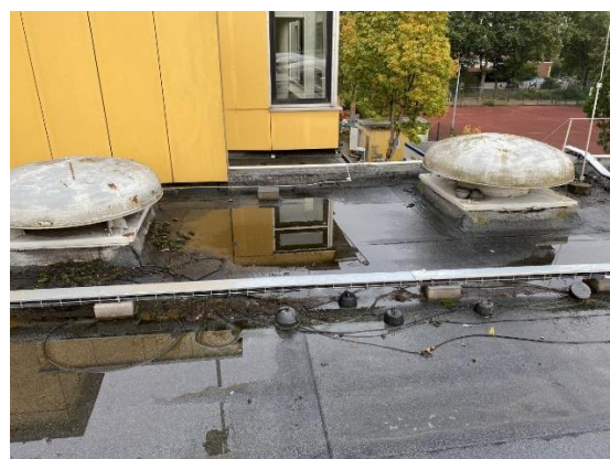
links Abluftanlage Hallenteil im Deckenholraum / rechts Abluftausblas und Außenluftansaugung
