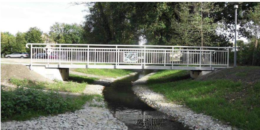
Beispiel einer Brücke aus Stahl oder Aluminium
