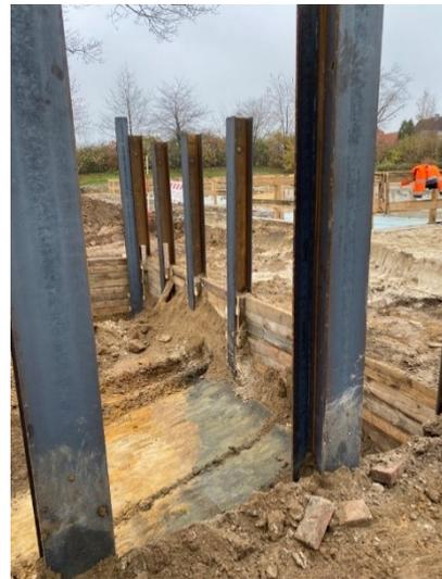
Bild 2: Verbau Schwallwasserbehälter
