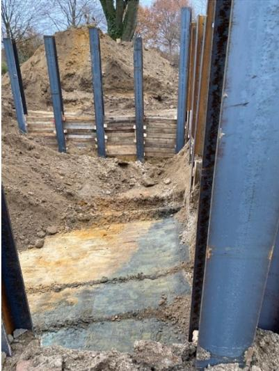
Bild 1: Verbau Schwallwasserbehälter, Stand 02.12.2022
