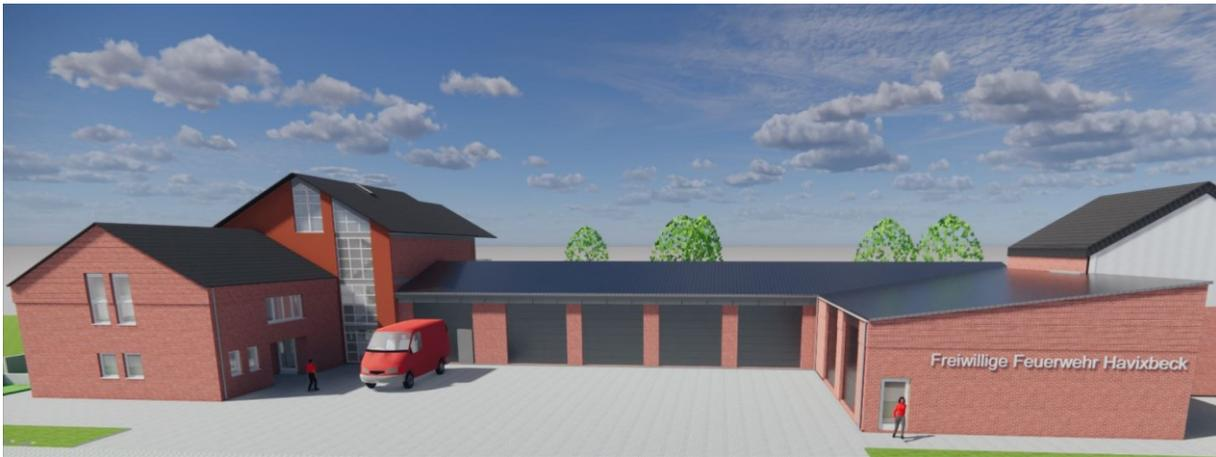
Der Beirat war mit der Variante 2 Verblendung der Giebel mit versetzten Ziegelreihen in der monatlichen Sitzung am 23.11.2022 damit einverstanden. Die Stütze in den Torbereichen werden bei dieser Variante mit Rockpanel Fassadenplatten ausgebildet. Der Frontbereich des bestehenden Feuerwehrgerätehauses erhält ein Wärmedämmverbundsystem.
