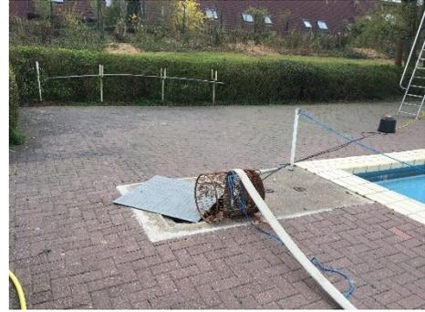
Im Rahmen der technischen Sanierung wird der obere Schachtteil abgebrochen. Ca. 30 cm unter der Pflasteroberfläche wird eine neue Betonabdeckung mit einer nahe des Beckenrands befindlichen Schachtöffnung hergestellt. Im Schacht befindet sich der Schieber für die Beckenentleerung.
