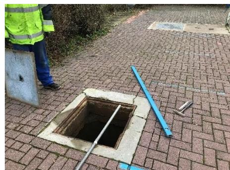
Der Schacht ist ca. 5,00 m tief und damit deutlich tiefer als die Beckensohle. Ob der Schacht einen Betonboden hat oder offen auf dem Untergrund steht, ist nicht bekannt. Der Schacht ist im Beckenumgang durch eine rechteckige Betonplatte mit einem Tränenblech zur Abdeckung der Schachtöffnung sichtbar. Die rechteckige Betonplatte,  $d = 35 \text{ cm}$ , ist auf einen runden Schacht aufgesetzt.
