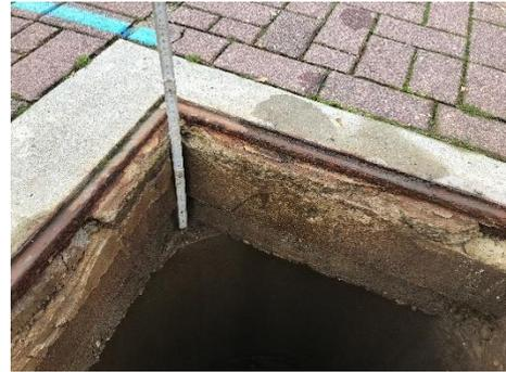
Wie bereits für den Beckenablassschacht ausgeführt, ist das Erscheinungsbild der Betonplatte mit der Tränenblechabdeckung wenig ansprechend, die Abdeckung ist abgängig und im Hinblick auf die Verkehrssicherheit im Barfußbereich problematisch. Für diesen Schacht wird in der Entwurfsplanung ebenfalls eine Erneuerung vorgesehen.
