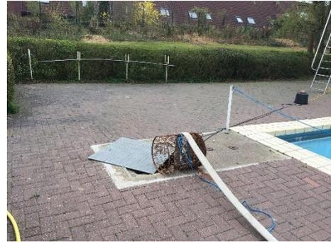
Wird der Schieber geöffnet, strömt das Wasser in den Schacht ein und staut sich im Schacht bis auf die Höhe eines im Schacht befindlichen Gerinnes an<sup>1</sup>. An der Sohle des Gerinnes ist eine Rohrleitung angebunden, die zum Abwasserschacht in der nordöstlichen Ecke des Beckenumgangs führt. Über diese Rohrleitung fließt das über die Überlaufkante des Gerinnes
