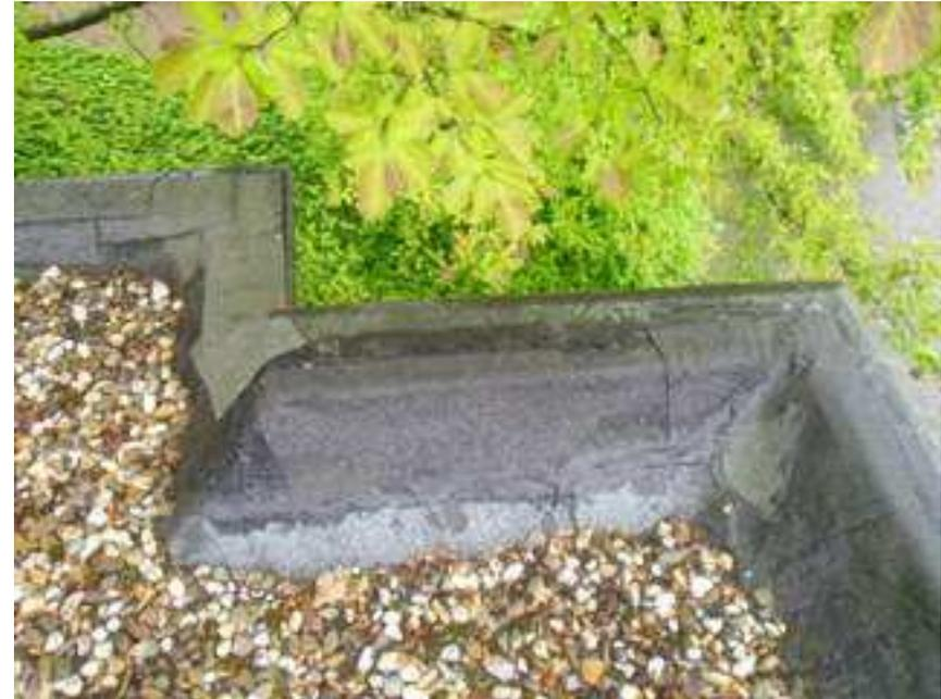
**Das mit Kies abgedeckte Bitumenpappdach ist ungepflegt, sodass ein wildes Gründach entstand, das die Entwässerung einschränkt.**
