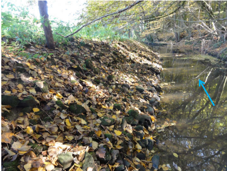
Abbildung 9: typisches Bild im unteren Maßnahmenbereich, massive Böschungssicherung am linken Ufer (Acker), das rechte Ufer im Bereich der Waldfläche ist frei von Uferverbau, Blick in FR
