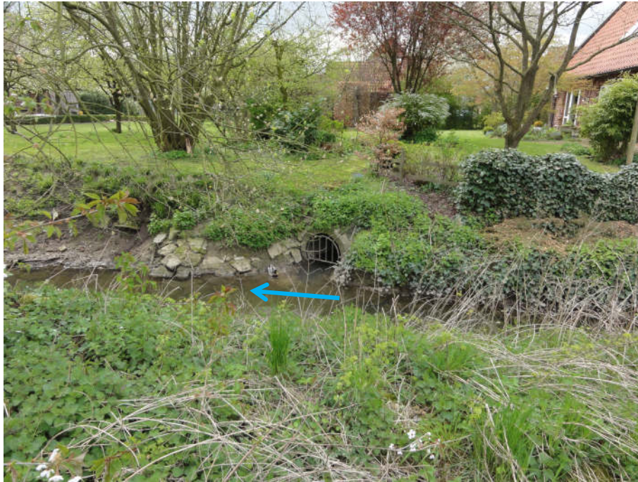
Abbildung 7: vorh. NW-Einleitungsstelle DN 800
