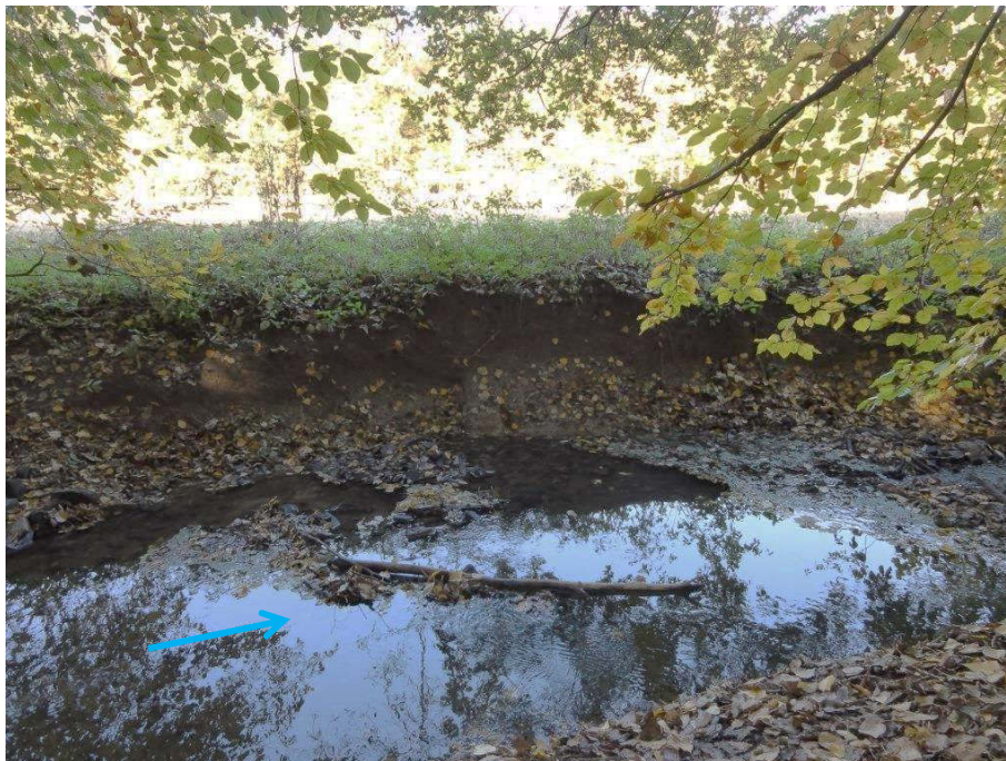
Abbildung 11: unterer Maßnahmenbereich, Kastenprofil , Blick vom rechten Ufer
