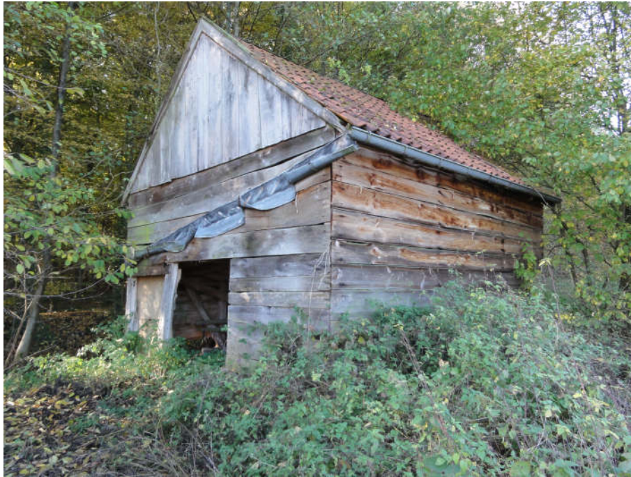
Abbildung 8: ehem. Schuppen im unteren Maßnahmenbereich
