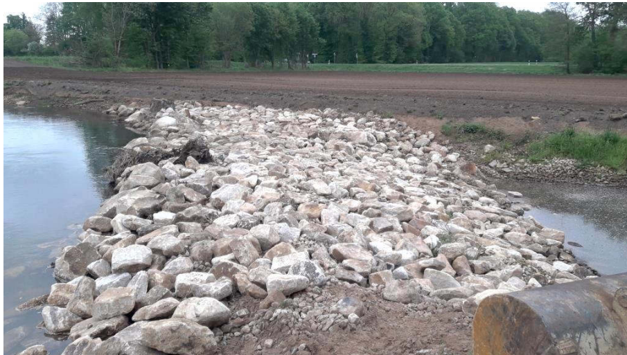
Abbildung 36: massiver Leitdamm in der Bever am Kloster Vinnenberg
