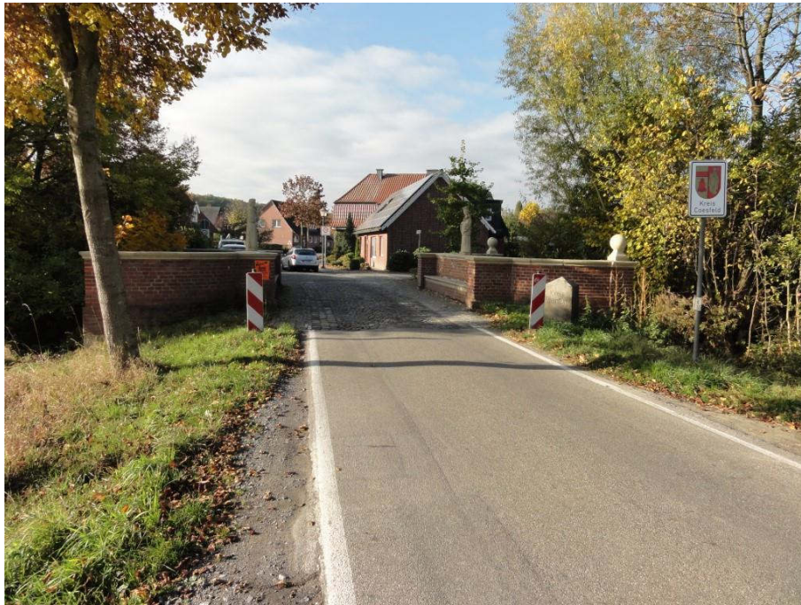
Abbildung 3: Blick von Osten auf die Brücke
