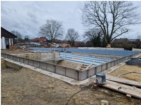
Bild 4: Metallarbeiten am Schwimmerbecken
